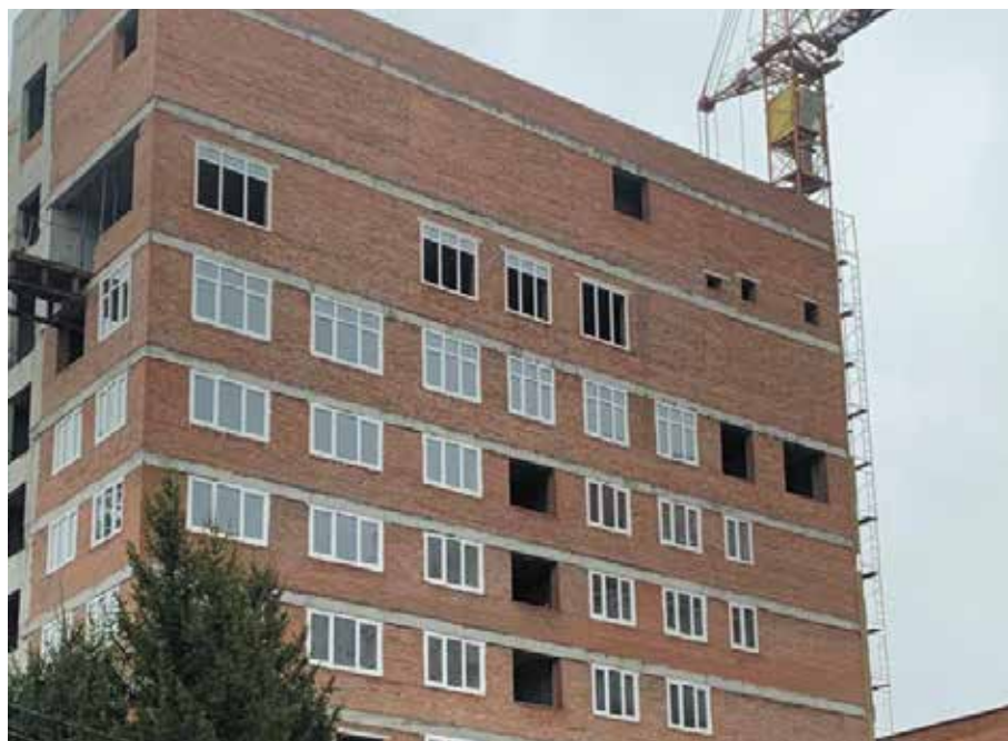
Строительство Хирургического корпуса Томского областного онкологического диспансера
